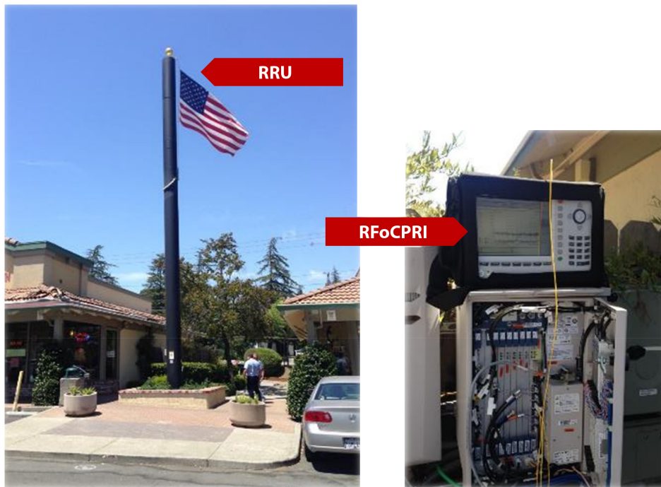
Abbildung 26: Kleinzelle und CellAdvisor mit RFoCPRI
