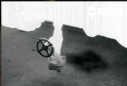
METHANLECK AN EINER ERDGASANLAGE
